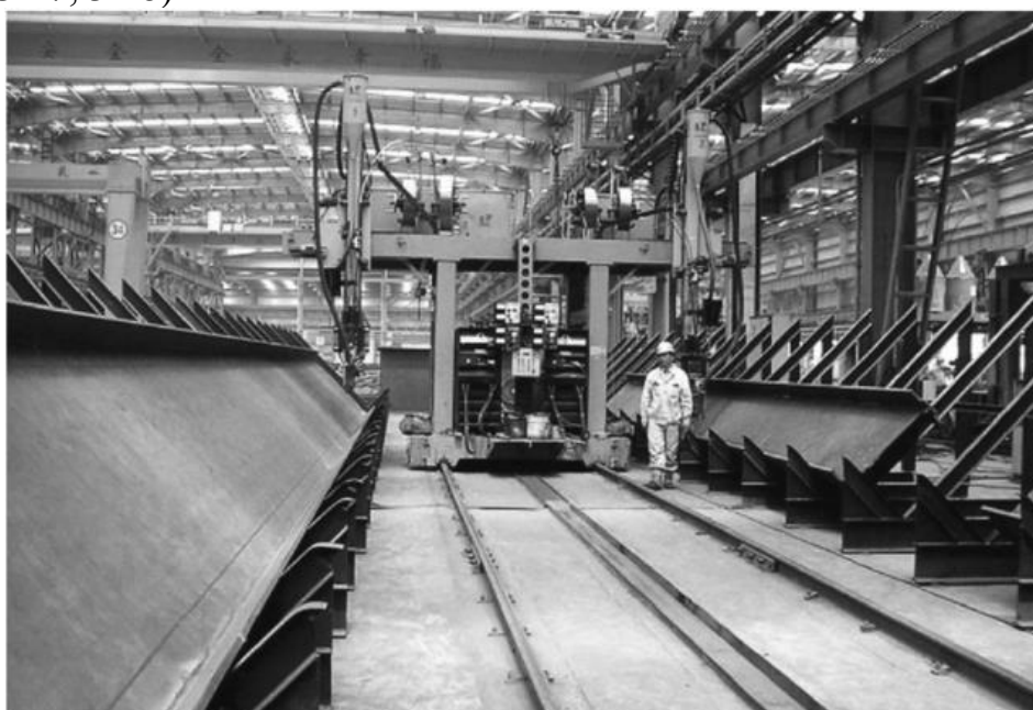
Рис.4. Сварка под флюсом двутавровых балок
